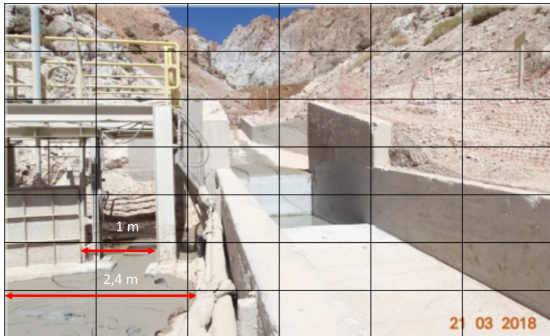
Figura 1. Derrame de lamas ingresando a la obra hidráulica IPA2 (Fotografía 1, Informe SMA)
